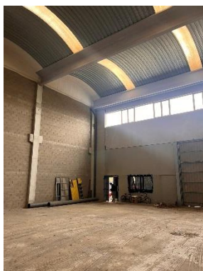
Paret lateral de blocs. Tallafoc en l'enfrontament de coberta amb veí
