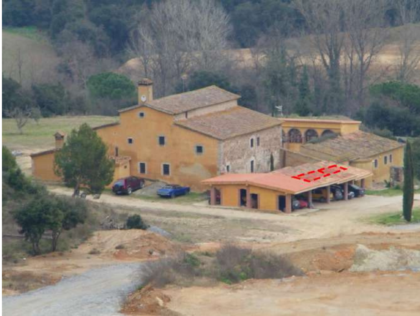
MUNTATGE DEL COMPLEX AMB LES PLAQUES
