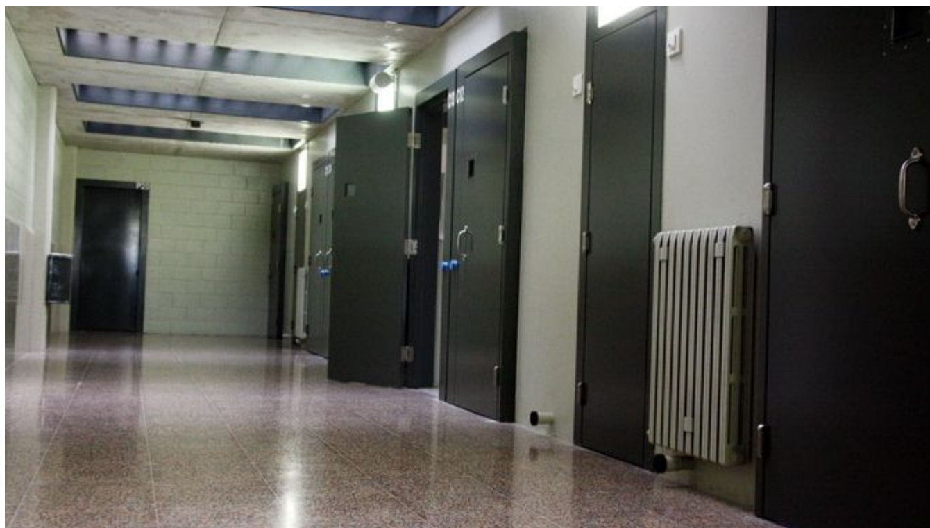
Passadís d'un mòdul d'un centre penitenciari (ACN/Fuentes B.)
