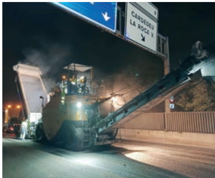
Les obres del túnel de Parpers van acabar dimecres passat
