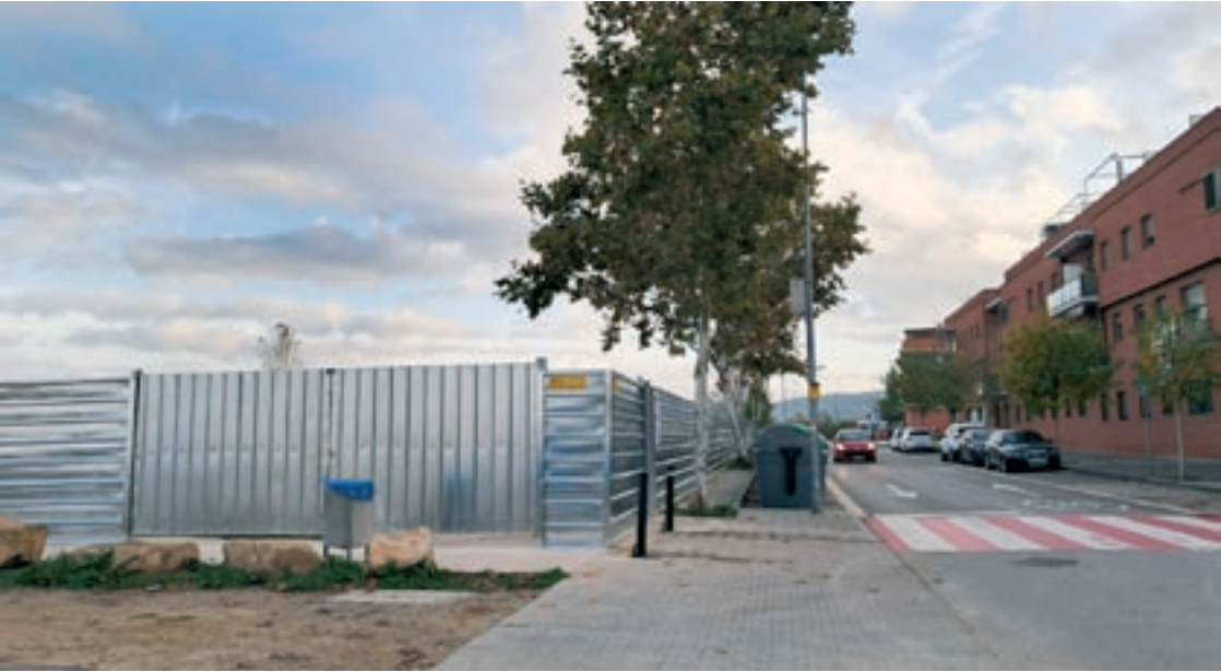
La promotora ja ha col·locat la tanca per començar a fer les obres de construcció dels habitatges
