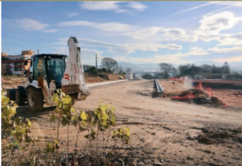
Obres al Sector Central de Parets del Vallès, a la cruïlla de l'avinguda Catalunya amb la Pedra del Diable
