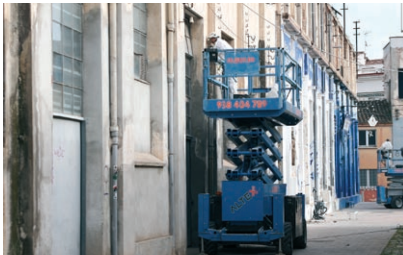
Un dels treballadors que durant la setmana passada va estar a Roca Umbert retirant els baixants
