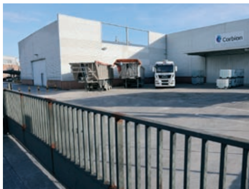
Corbion ha modernitzat les calderes de la planta de Montmeló
