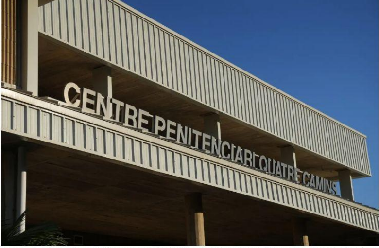
rchivo - Fachada del Centro Penitenciario de Quatre Camins, a 12 de noviembre de 2025, en Roca del Vallès, Barcelona, Catalunya (España) - David Zorrakino - Europa Press - Archivo
