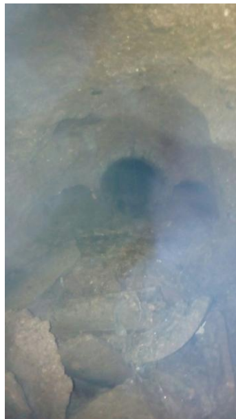
Trencament a pocs metres del pou de registre
