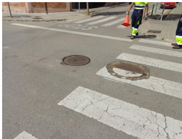
Cantonada C/Granada pou residual i pluvial
