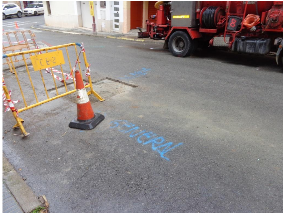
Traçat de la canonada d'abastament d'aigua potable i encreuament de ramal.
