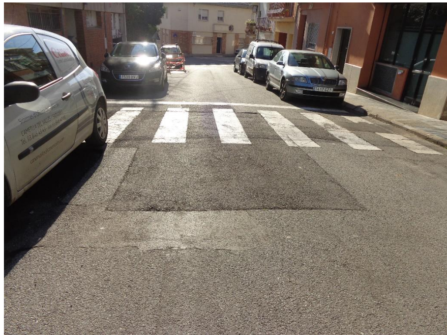
Antiga reparació clavegueram al carrer Canàries
