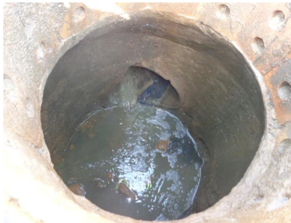
Pou residual a la cantonada C/Granada
