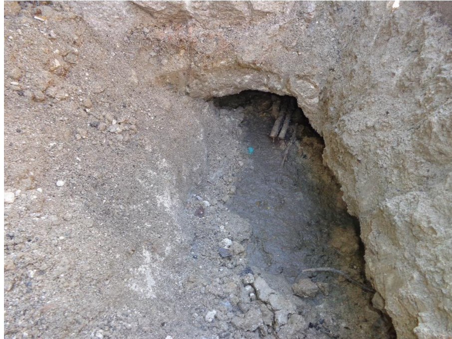
Rasa realitzada per la companyia d'aigües per on sortia aigua residual
