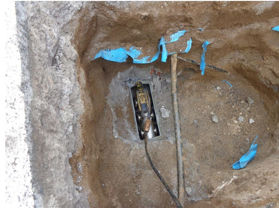
Antiga reparació clavegueram al carrer Canàries. Tub de PVC DN200 mm
