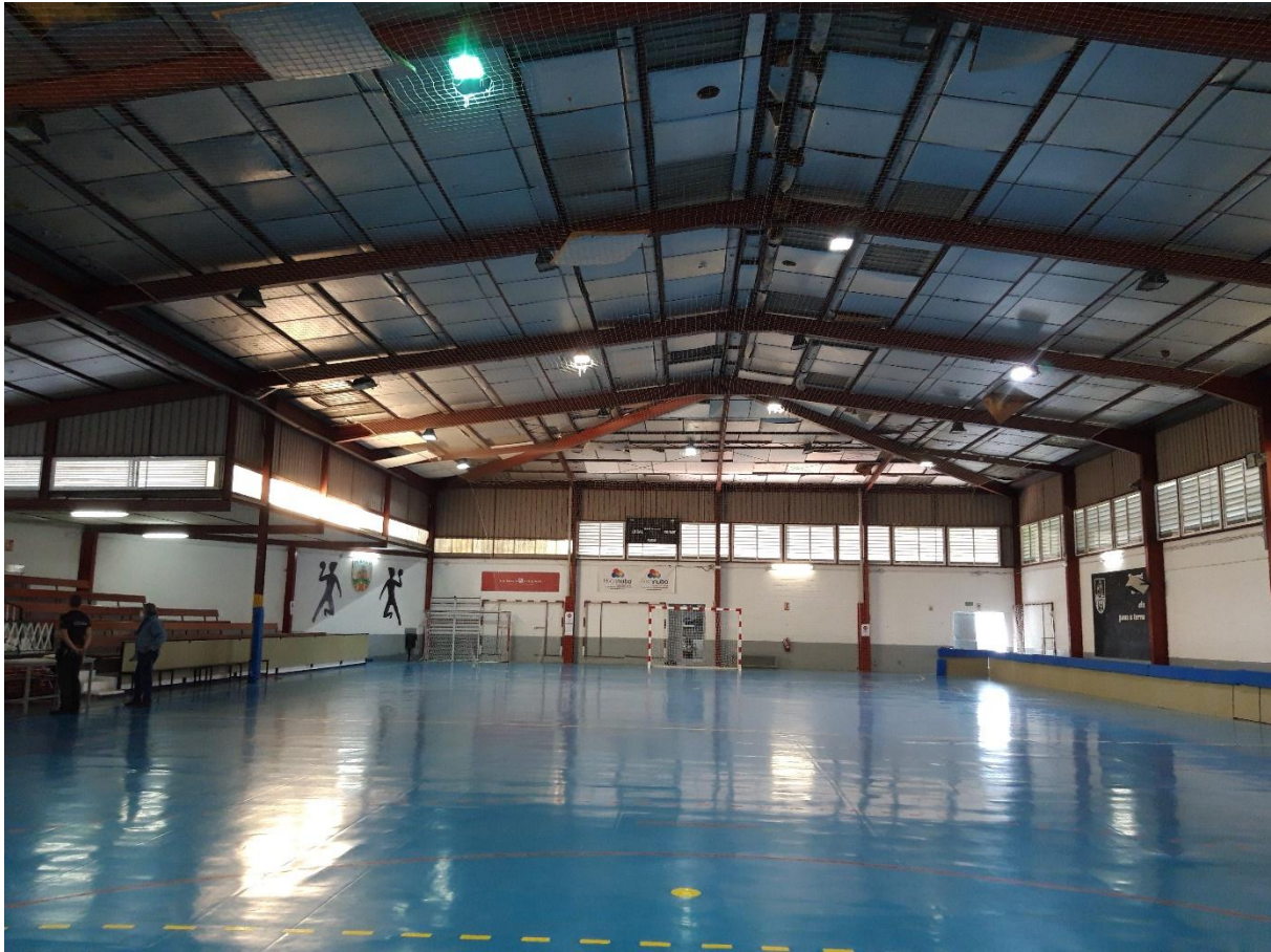
Nau central, foto en direcció longitudinal
