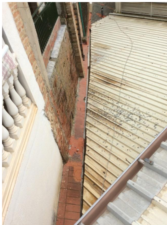
6. Canals de dimensions insuficients
